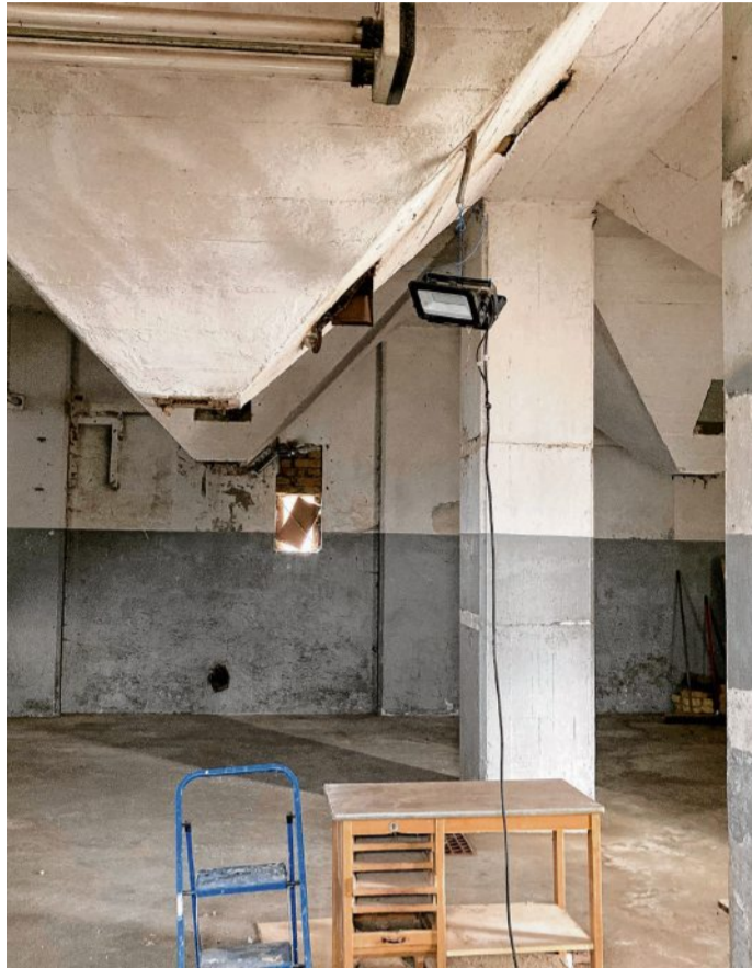
Die unverwechselbare Deckenkonstruktion im Eingangsbereich des Speichers ist noch erhalten.
